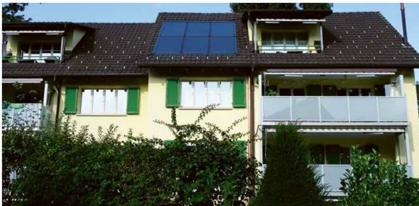
Beim Ersatz einer veralteten Technik für die Warmwasseraufbereitung (separate Elektroboiler in jeder Wohnung) durch einen Zentralboiler pro Gebäude, wollte die MBG in einem Pilotversuch im Haus Nordstrasse 15 prüfen, wie sich die Warmwasseraufbereitung durch die bestehende Gasheizung mit Solarkollektoren auf dem Dach unterstützen lässt. Die beiden anderen Häuser Nordstrasse 11 und 13 könnten – bei guten Erfahrungen – nachträglich noch mit Solarkollektoren nachgerüstet werden.
